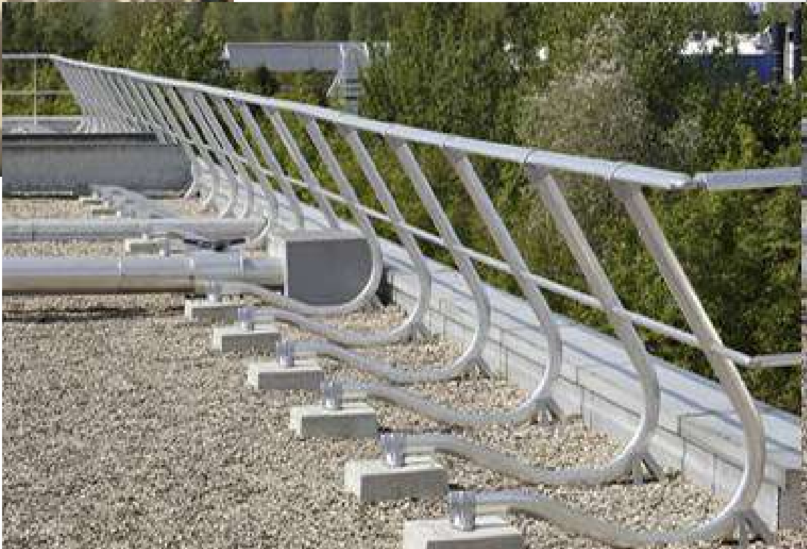
parapetto permanente autoportante fisso su copertura piana
